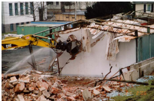
Abriss der Laborhalle
